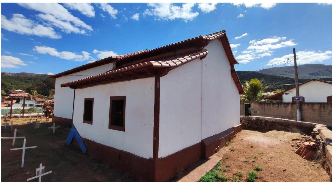
*Restauração emergencial do telhado da Capela, incluindo a troca de todo telhamento, ripamento e peças estruturais danificadas*
